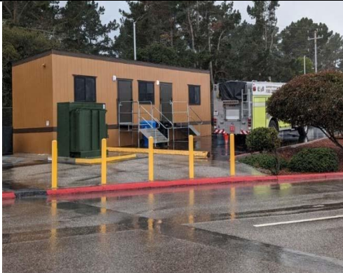
Remolque modular "parque de bomberos" en el aeropuerto
