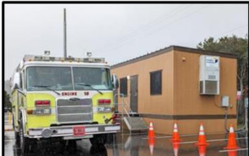
Motor 16 en el remolque modular del lado sur del MFD Fuente: Fotografía tomada por el Gran Jurado Civil
